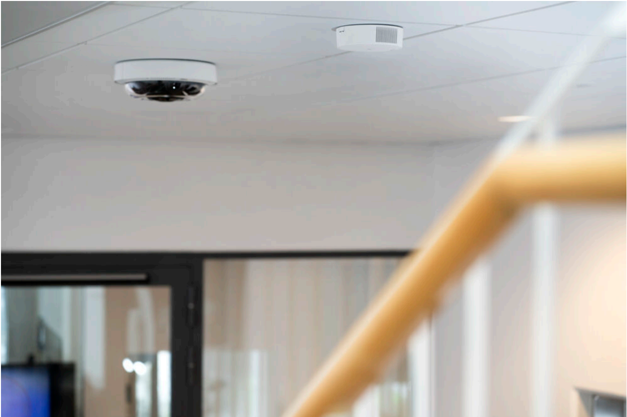
Ein Sensor für die Luftqualität und eine Kamera, die als Host-Gerät dient.
