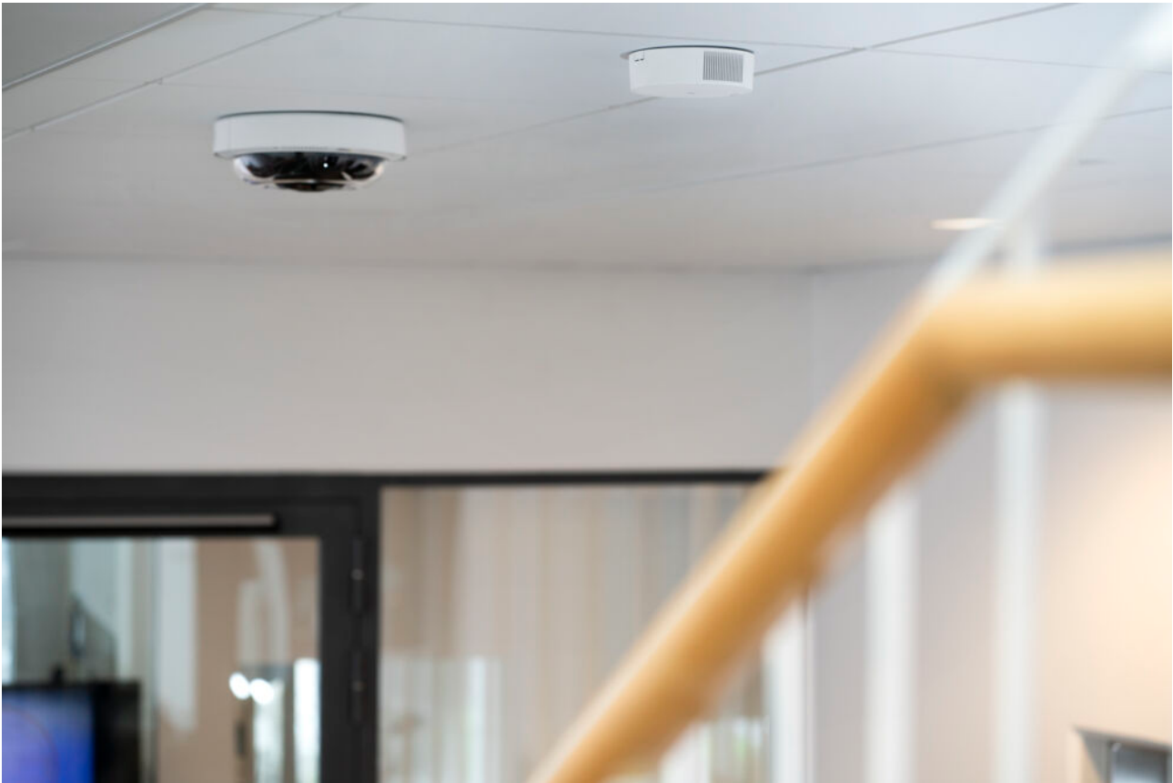
Ein Luftqualitätssensor (rechts) erweitert Ihr Sicherheitssystem über eine Kamera (links), die als Host-Gerät dient, zur Überwachung der Luftqualität.
