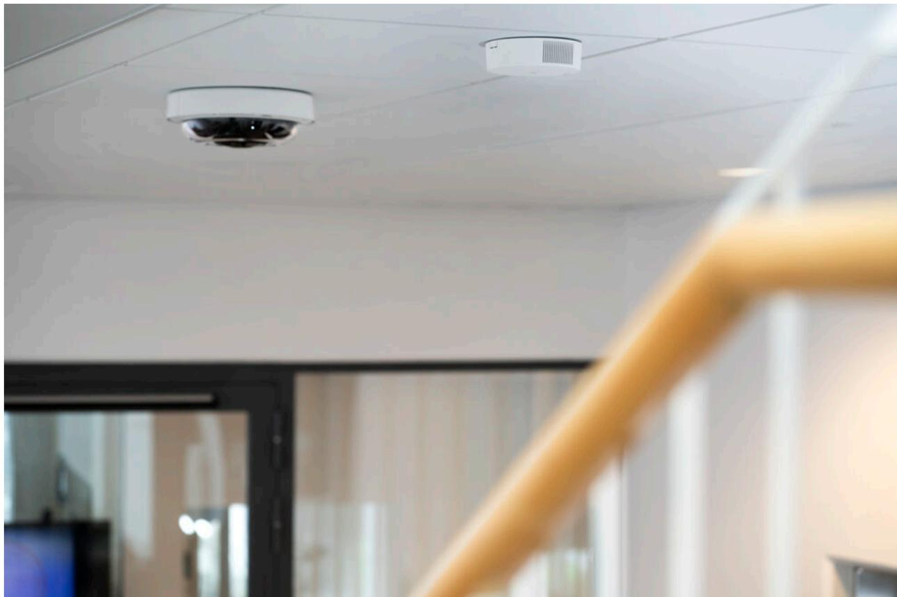
*Un sensor de calidad del aire y una cámara que actúa como dispositivo host.*
