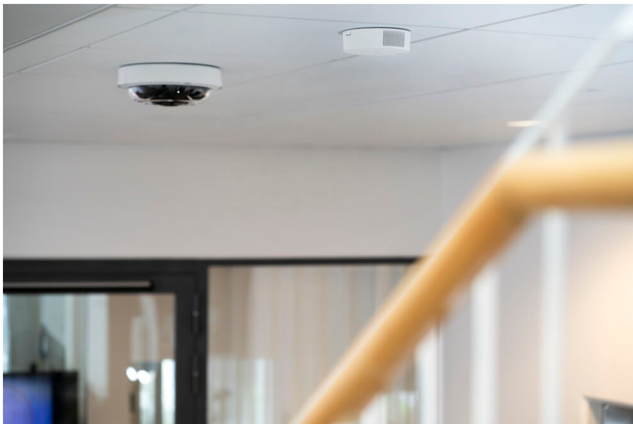
Un capteur de qualité de l'air et une caméra servant de périphérique hôte.
