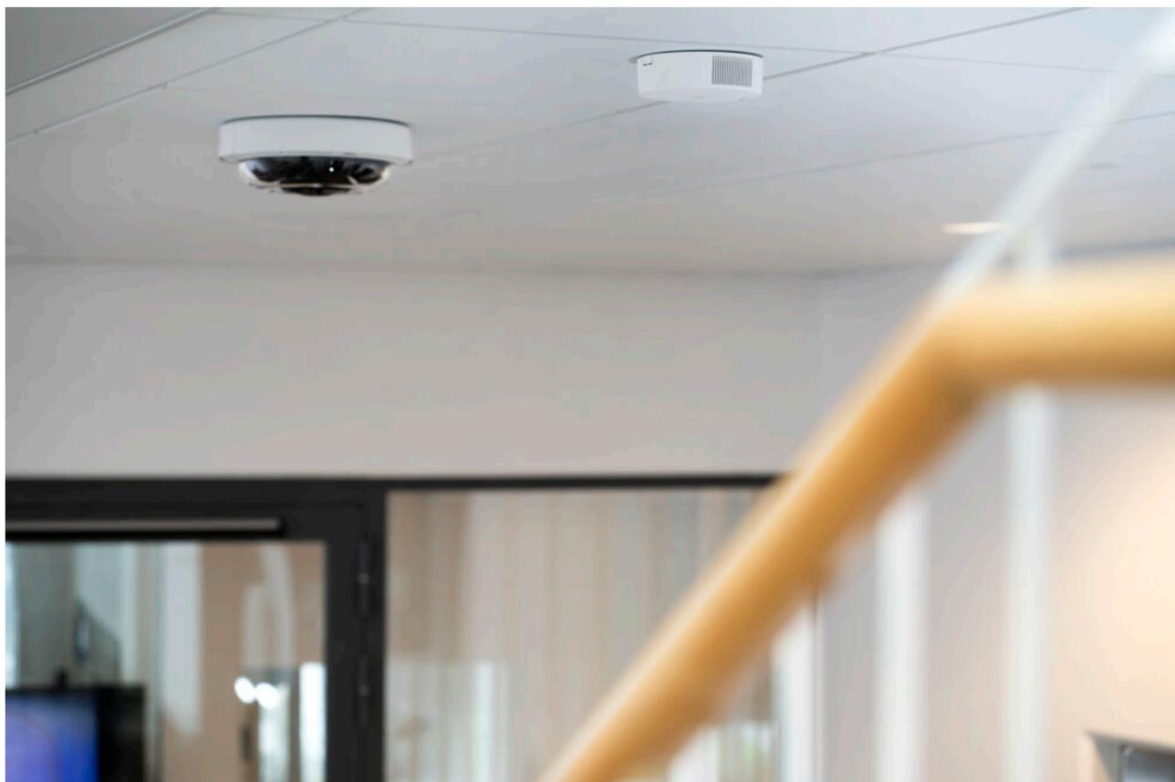
*Un sensore della qualità dell'aria e una telecamera che funge da dispositivo host.*
