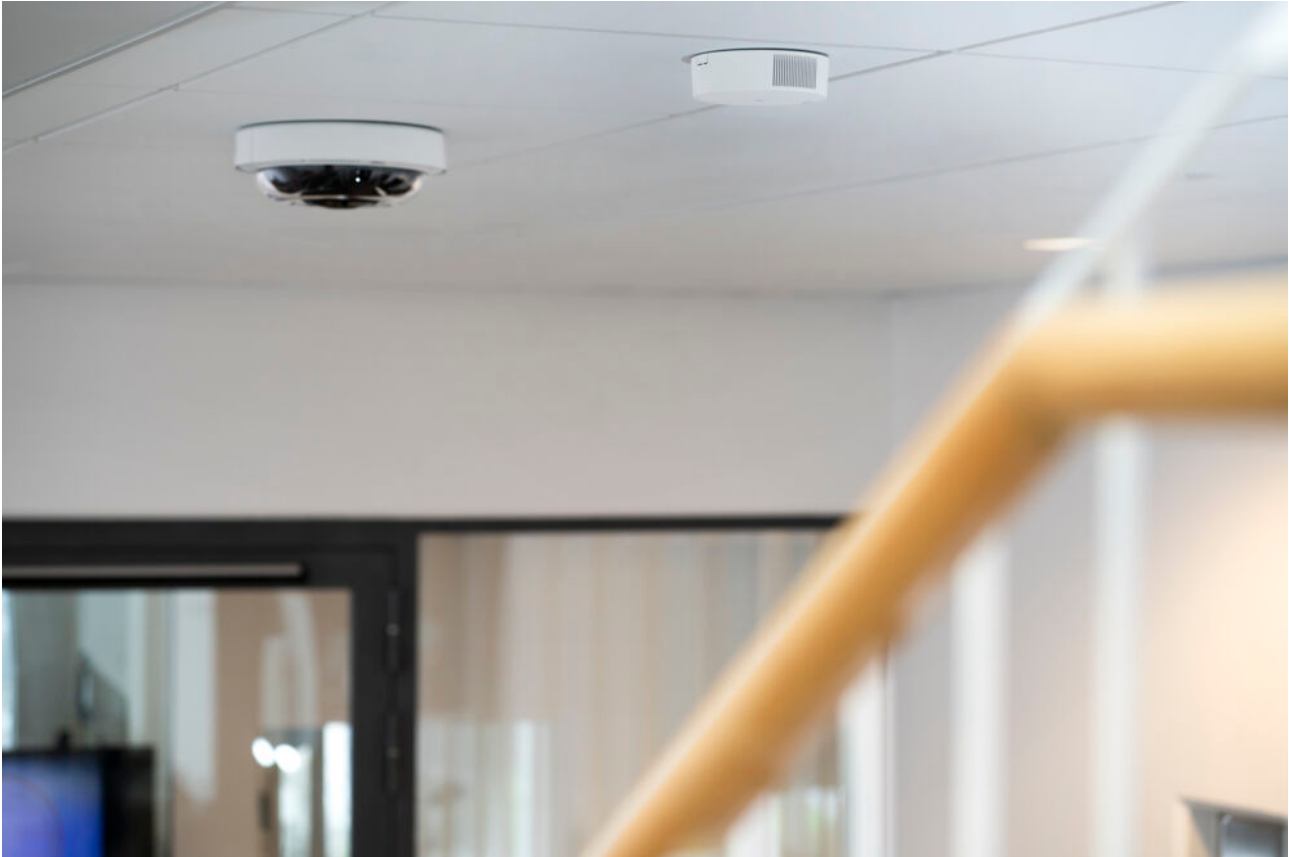
空気質センサーとホストデバイスとして機能するカメラ。
