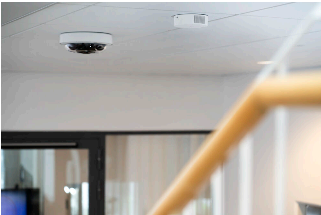
Czujnik jakości powietrza i kamera pełniący funkcję urządzenia nadrzędnego.
