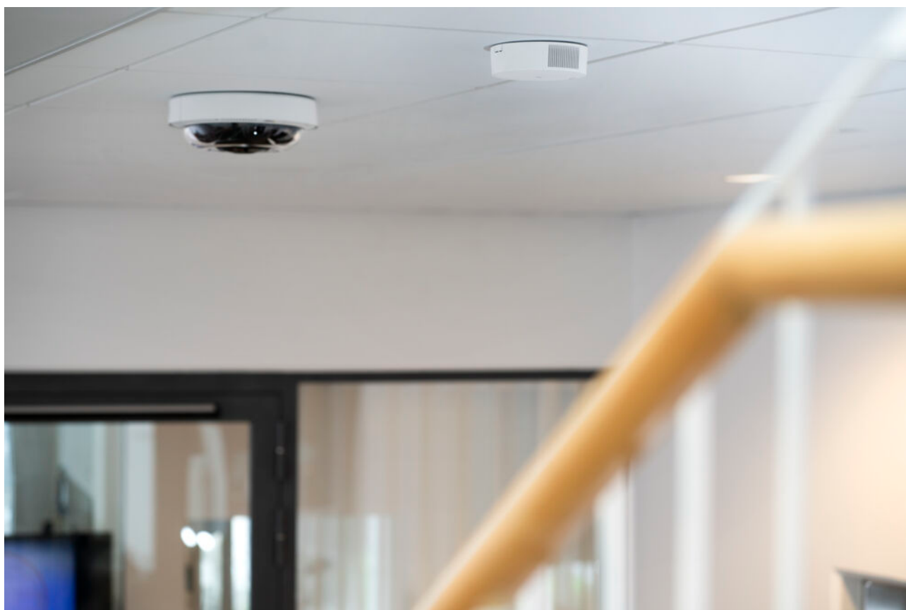
Um sensor de qualidade do ar e uma câmera que serve como dispositivo host.
