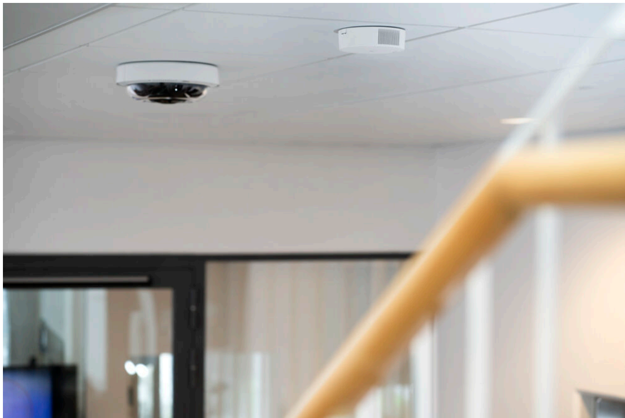
一个空气质量传感器搭配一台作为主机设备的摄像机。
