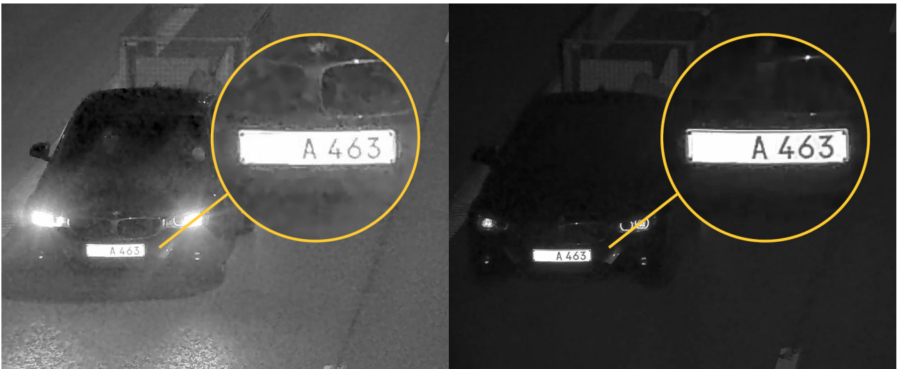
Ujęcia wykonane w trybie nocnym (z lewej) oraz z filtrem pasmowo-przepustowym podczerwieni (z prawej). Oba ujęcia zostały wykonane kamerą PTZ AXIS Q6355-LE PTZ Camera z odległości 50 m (55 yd) z 7-krotnym zoomem optycznym.
